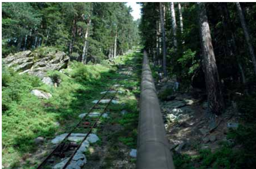
Bild 2 Die zu ersetzende Druckleitung.
