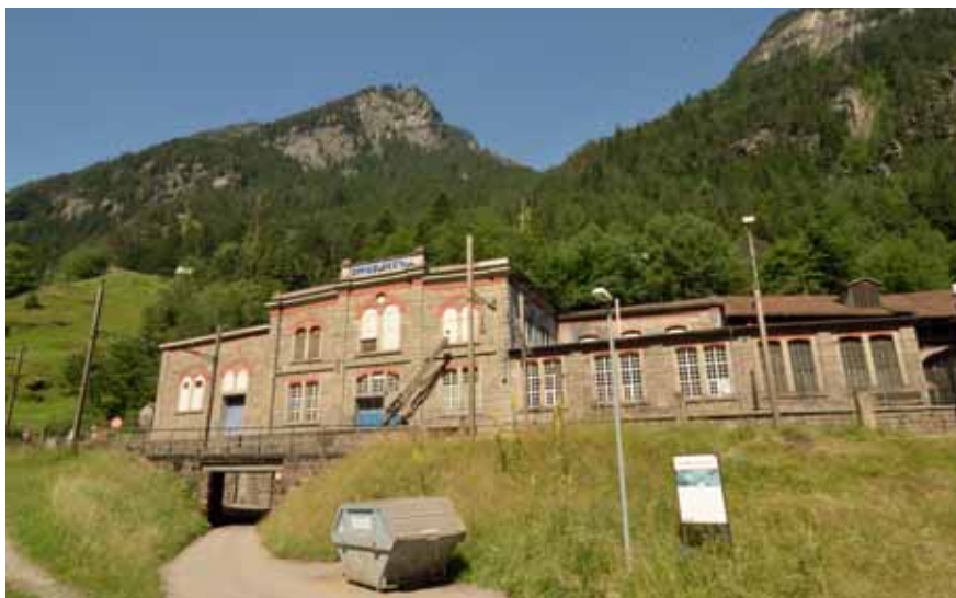
Bild 1 Kraftwerksgebäude in Gurtellen.
