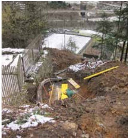
Erstellen von Werkleitungen.
