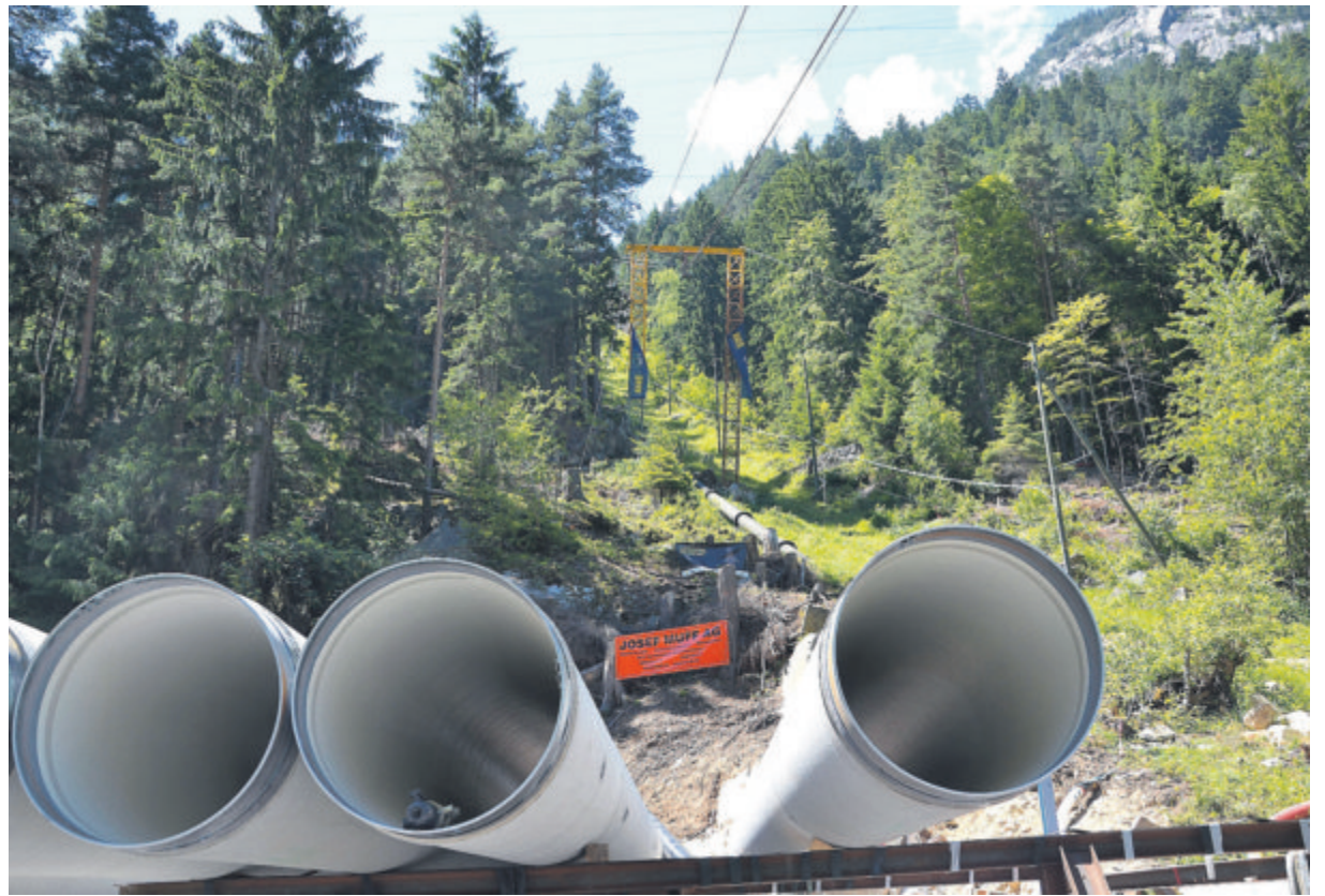
Die über 100 Jahre alten und 1,7 Kilometer langen Druckrohrleitungen werden ausgetauscht.
