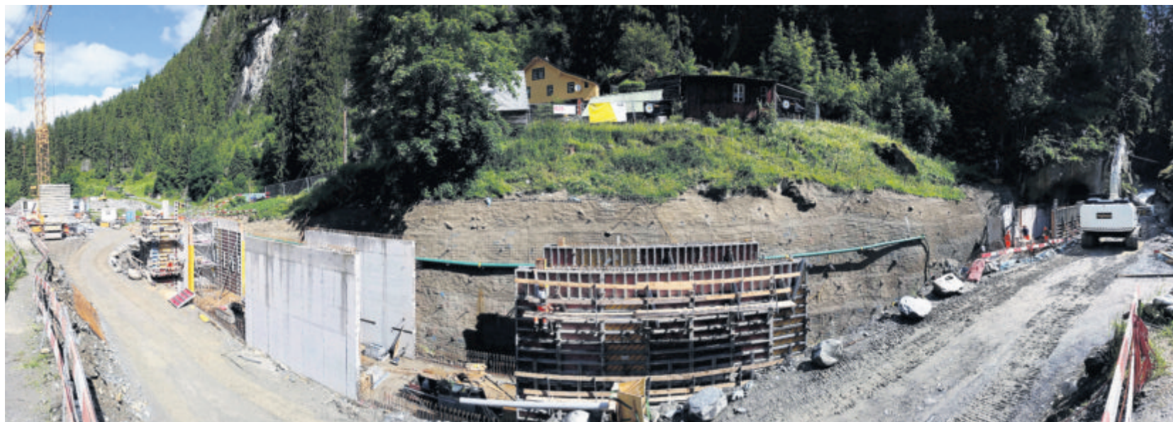
Die Arbeiten für die Wasserfassung in der Läggi – hier in der Panoramaansicht – für das neue Kraftwerk Bristen AG schreiten zügig voran.
