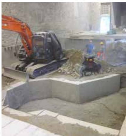
Aushubarbeiten in der Kraftwerkzentrale.
