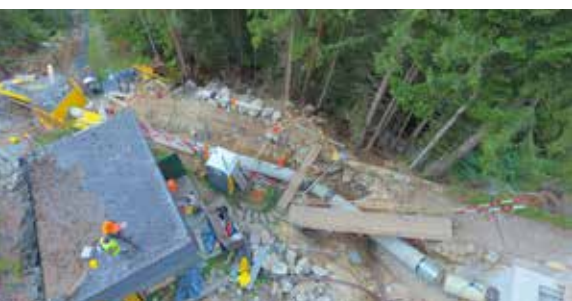
Druckleitungsbau im Abschnitt der Bergstation Standseilbahn
