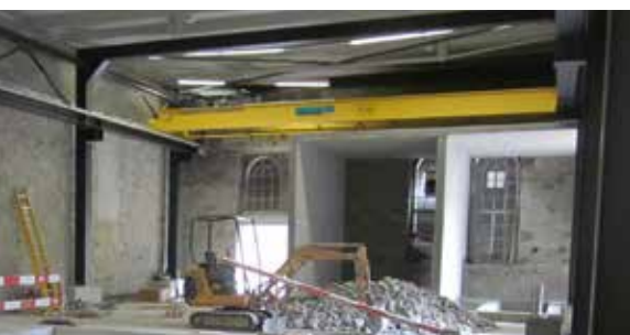
Kraftwerkzentrale mit neuer Krananlage
