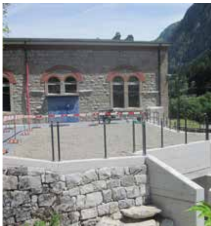
Vorplatz mit Unterwasserkanal im Bereich Kraftwerkszentrale
