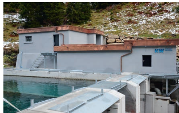
Die neue Wasserfassung des Kraftwerks Gurtneilen auf rund 1400 m. ü. Meer.
