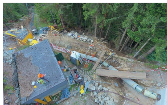
Die Verlegung der neuen Druckleitung im alpinen Gelände war eine grosse Herausforderung.
