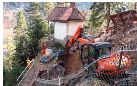
Die Baustelle führte direkt an der bekannten Wallfahrtskapelle im Stäubenwald vorbei.
